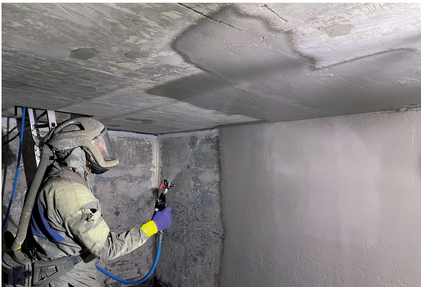
EFFEKTIVT. I januar gjennomførte Gjæco, Opticon Solutions og Norske Skog Saugbrugs, det første fullskala testprosjektet med den nye epoksysparkelen. Sparkelen kan sprøytes jevnt på vertikale flater uten at den siger eller drypper.
