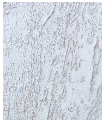
Teknos Tranemo äkta linoljefärg (44) Vindeln. Krackelering.
