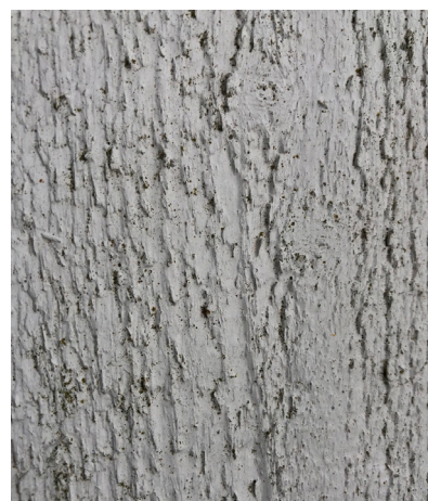
Clas Ohlson (31) Alnarp. Alg och mögelpåväxt.
